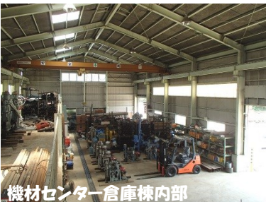
機材センター倉庫棟内部
