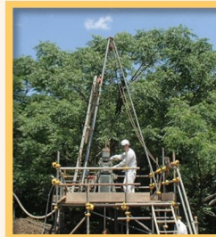
調査ボーリング
