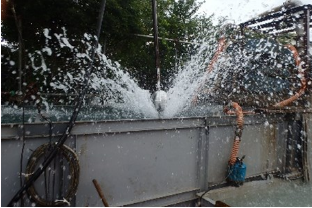
図-2 水井戸洗浄用大型ノズル
