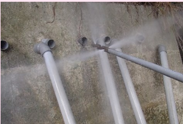
図-4 高圧水・圧縮空気混合タイプ小型洗浄ノズル (自社開発) >
