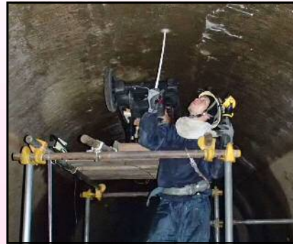
覆工厚、緩み領域の測定
