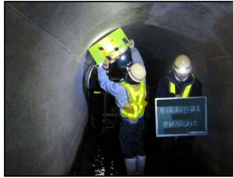
横断方向のレーザー探査
