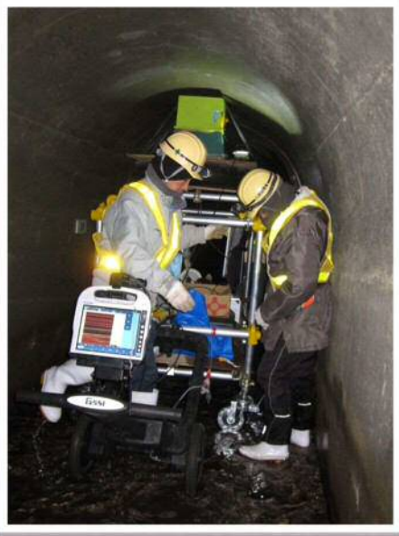
導水路の大きさに合わせて組み立てた架台
