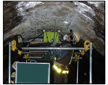
覆工厚、緩み領域測定のための削孔
