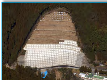
<県道災害対策法面>
