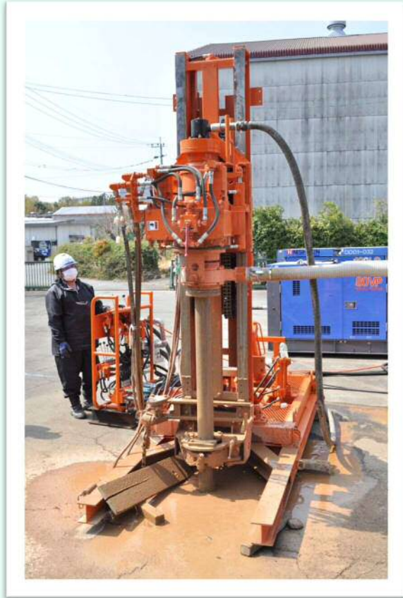
<下向き90° 穿孔状況>
