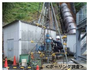
<ボーリング調査>
