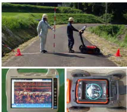
写真-1 探査状況及び探査器
