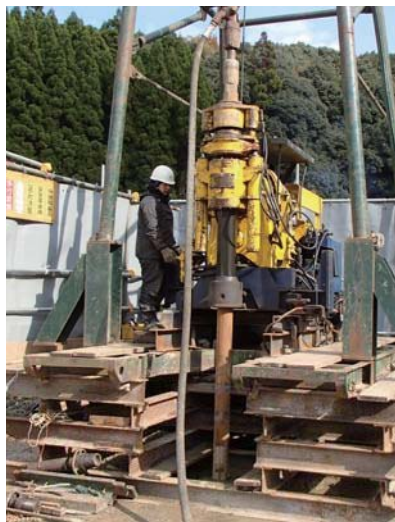
写真1. 八洲開発社のボーリング
